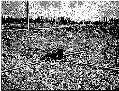
วางท่อน้ำระบบสปริงเกอร์ ในแปลงหญ้าขนจำนวน 15 ไร่
