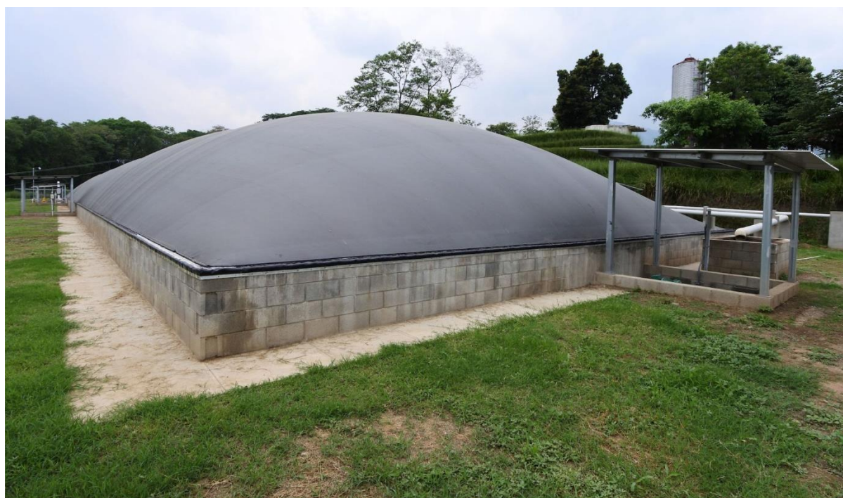
ภาพที่ 4 บ่อหมักย่อยแบบไม่ใช้ออกซิเจนเพื่อผลิตก๊าซชีวภาพ
