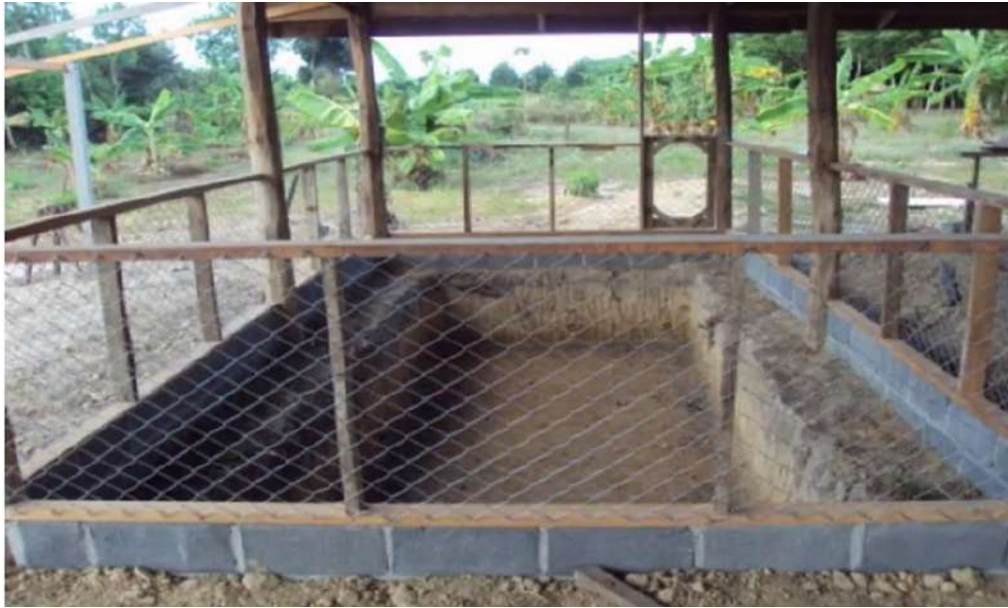
ภาพที่ 1.2 แสดงลักษณะการออกแบบคอกสุกรหลุมแบบขุดลงพื้น ที่มา : รวมพลคนเลี้ยงหมูหลุม ครั้งที่ 3
