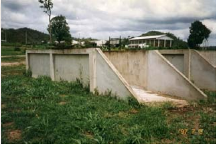
หลุมหมักแบบกำแพงคอนกรีต (ขนาดกว้าง 1.6 ม. ยาว 5 ม. สูง 1 ม.)
